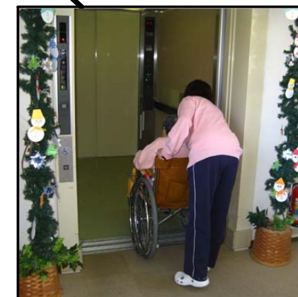
エレベーター
